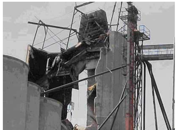
Fig. 1 e 2 – O sistema de transporte e armazenamento de grãos de trigo foi parcialmente destruído por uma explosão de nuvem de pó. A investigação do evento apontou “descarga eletrostática” como provável fonte de ignição.
