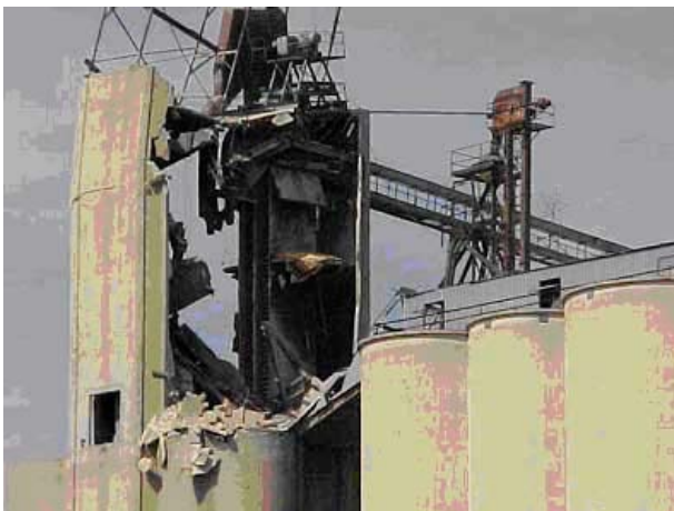
Fig. 1 e 2 – O sistema de transporte e armazenamento de grãos de trigo foi parcialmente destruído por uma explosão de nuvem de pó. A investigação do evento apontou “descarga eletrostática” como provável fonte de ignição.
