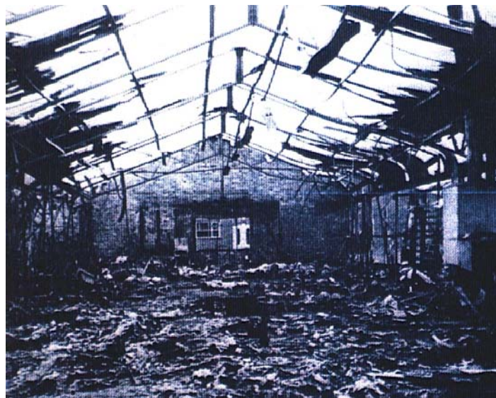
Fig. 1 – Resultado de uma reação em fase condensada envolvendo \text{H}_2\text{O}_2 , líquido orgânico e ácido sulfúrico
