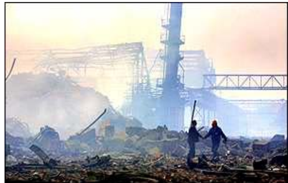
Figura 2- Acidente numa fábrica de fertilizantes, localizada na área urbana da cidade de Toulouse, França, em 21/09/2001, que resultou em 29 fatalidades e quase 900 feridos. Estas conseqüências poderiam ter sido dramaticamente reduzidas pelo princípio do isolamento.
