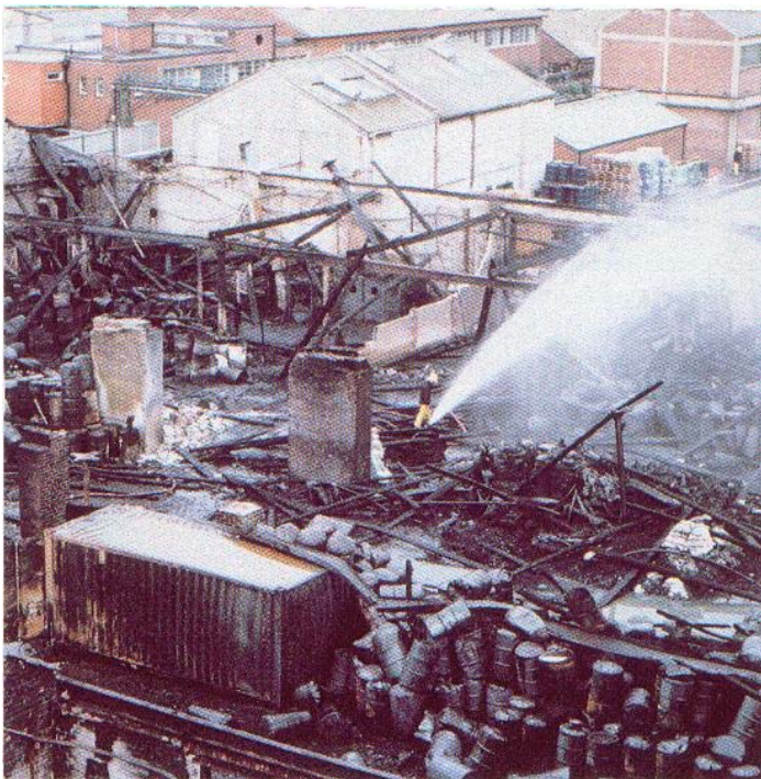
Fig. 1 - A investigação da ocorrência acima revelou que o evento foi iniciado pela decomposição térmica de um produto em pó.
